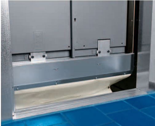
Beim Einfahren der Kabine in die unterste Haltestelle klappt die faltbare Schürze leise ein.
